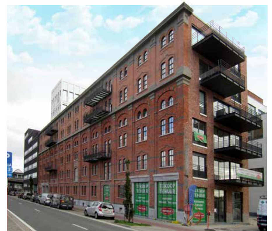
Om de link met het industriële verleden te behouden, bestaan de gevels grotendeels uit de rode baksteen die de oorspronkelijke site typeerde.
